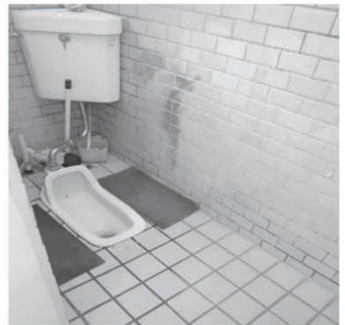
市内公園トイレ
